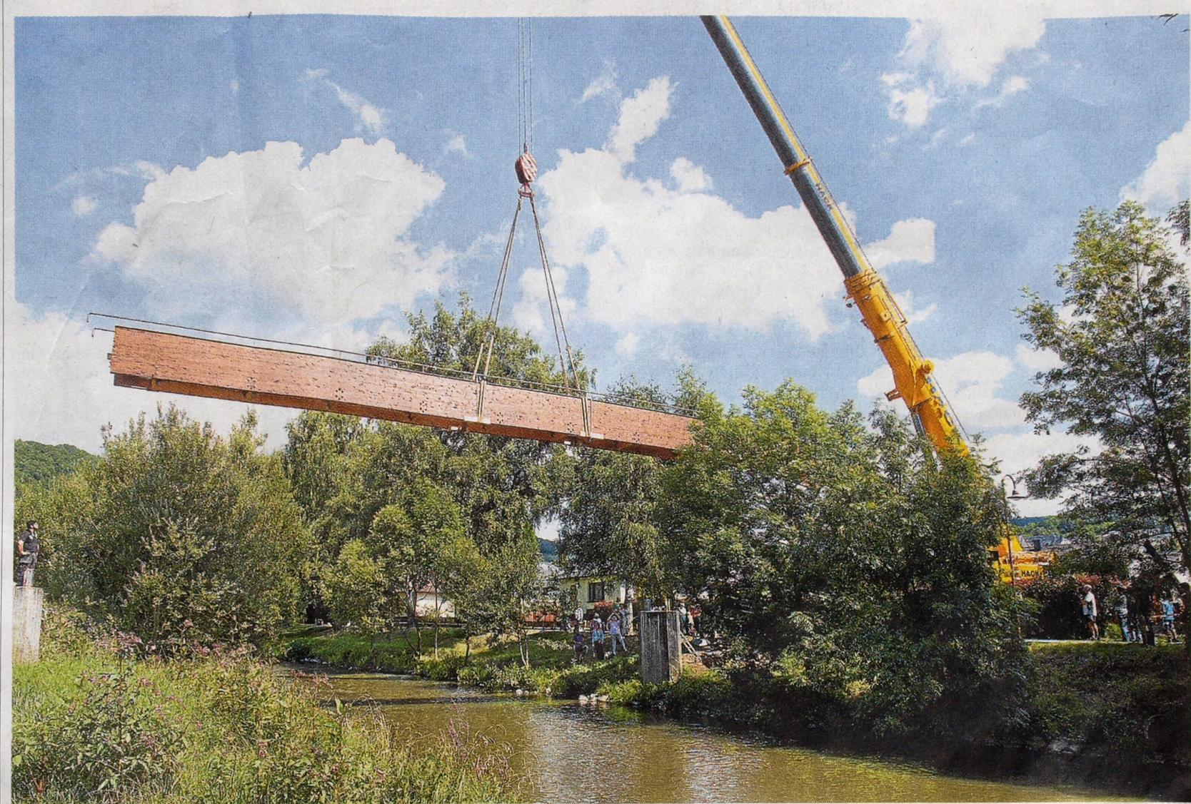
Mit einer Spannweite von 25 Metern und einem Gewicht von 6,8 Tonnen schwebt die neue Brücke über der Wied.
