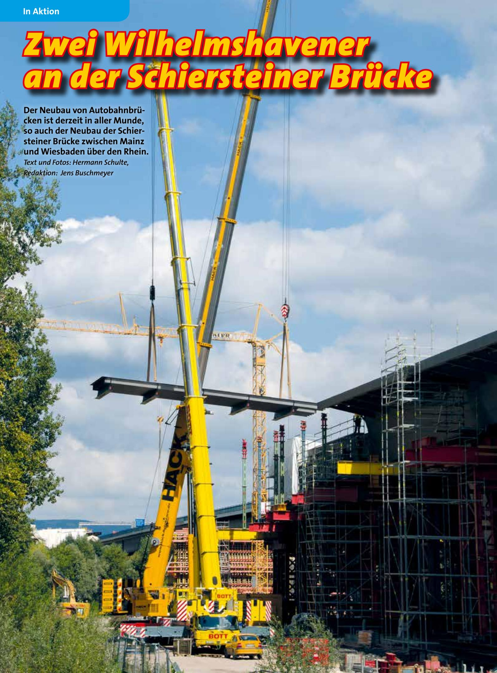
Der Bau gliedert sich in verschiedene Sektionen mit unterschiedlichen Bauvarianten. Dadurch sind auch unterschiedliche Kraneinheiten im Einsatz. Auf der rheinland-pfälzischen Seite bewährten sich nun zwei GMK-Krane aus Wilhelmshaven bei einem Tandemhub.
