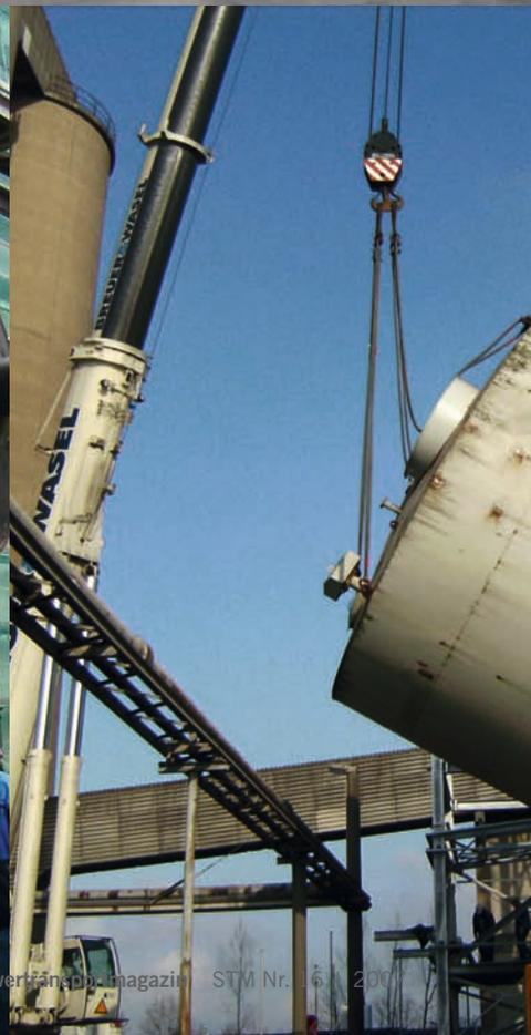
*Nachdem sich der Schwerlastzug unter der Betonbrücke positioniert hatte, nahm ihn die LTM 1400 an den Haken und legte ihn waagrecht ab. Dann wurde das Silo zum Aufrichten in die Senkrechte vorbereitet.*
