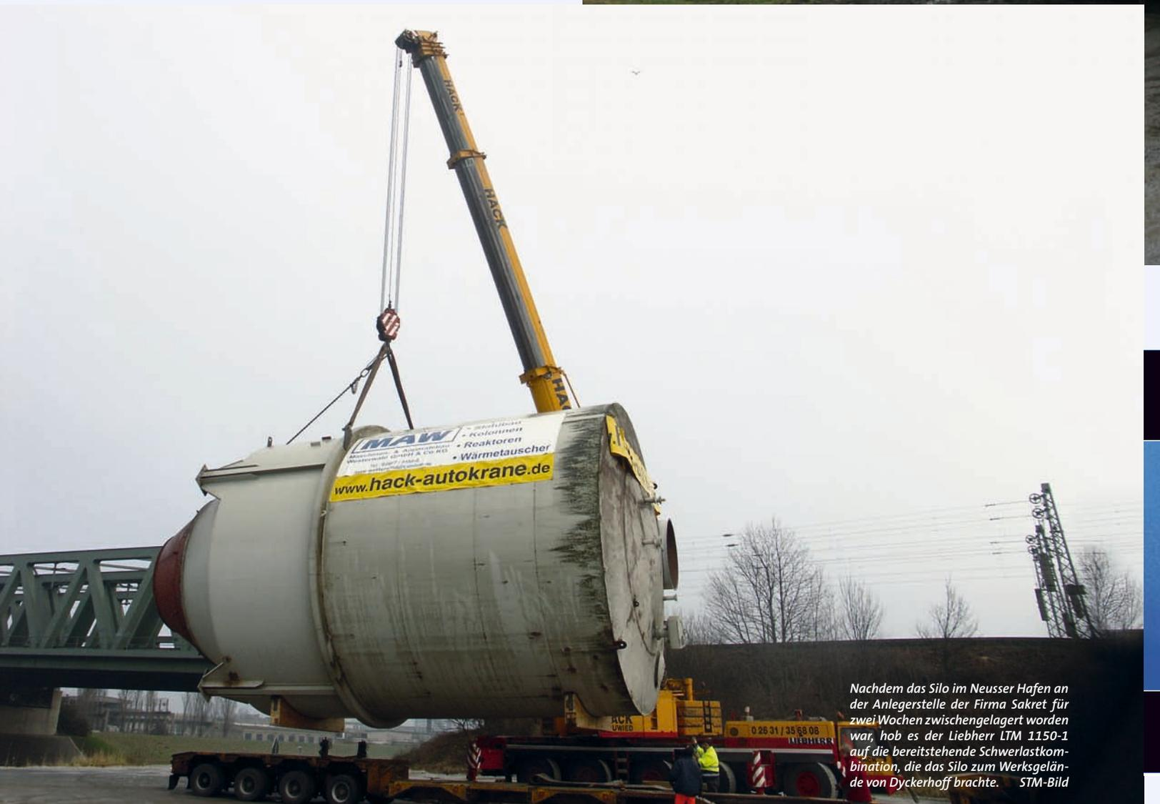
Nachdem das Silo im Neusser Hafen an der Anlegestelle der Firma Sakret für zwei Wochen zwischengelagert worden war, hob es der Liebherr LTM 1150-1 auf die bereitstehende Schwerlastkombination, die das Silo zum Werksgelände von Dyckerhoff brachte. STM-Bild
